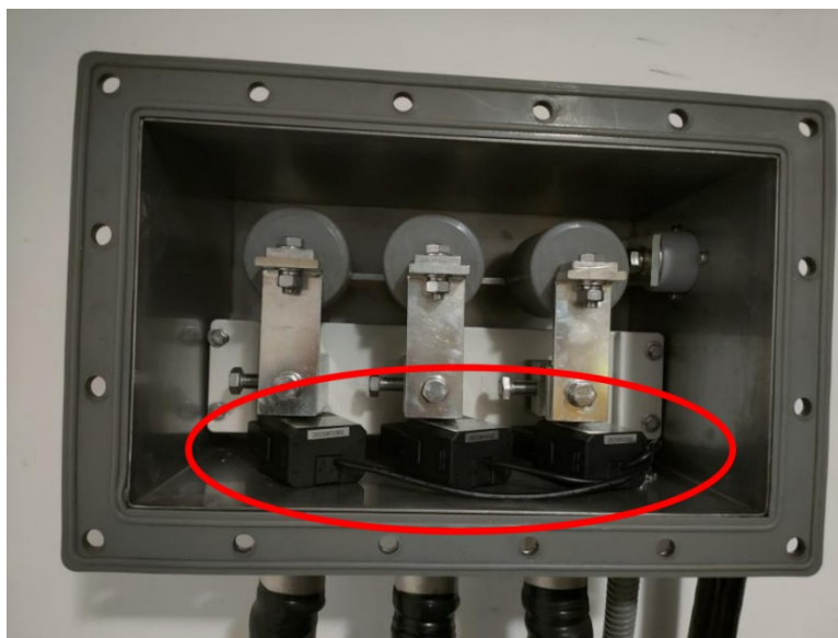
接地环流传感器安装图
