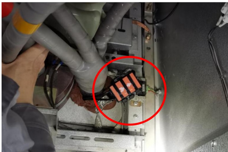
电流行波传感器安装图
