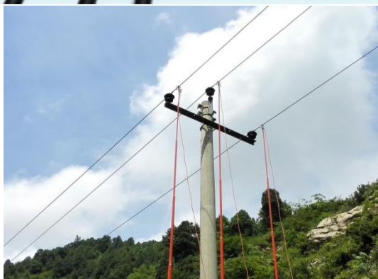
如图：将连接信号输出线的三个挂钩令克棒分别挂到故障线路的三相导线上。
